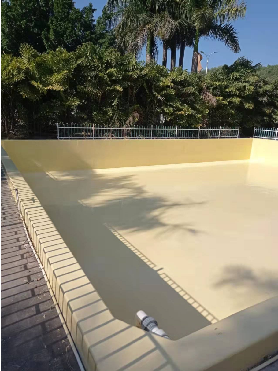
应急池防腐涂层修补后图片：
